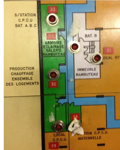
Vue du pupitre (horizontal) et du tableau synoptique (vertical) des alarmes de fonctionnement.
