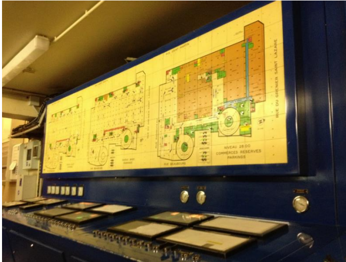
Vue du pupitre (horizontal) et du tableau synoptique (vertical) des alarmes de fonctionnement.
