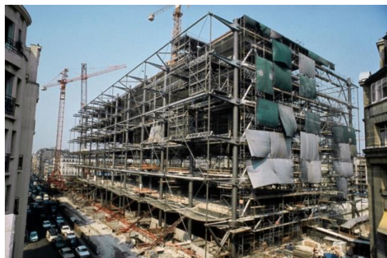
Construction du Centre Pompidou inauguré en 1977. (Photo Centre Pompidou).
