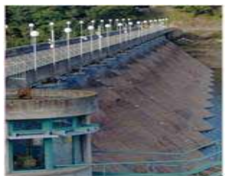
Revêtement de barrages
